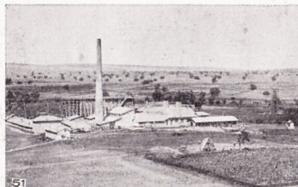
Провадия — Солосварната фабрика
